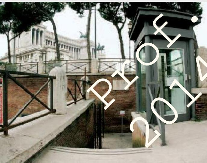
Roma, Mercati di Traiano. Piattaforma elevatrice a pantografo costituita da un piano di ferro protetto su tre lati da ringhiere. La scelta di una struttura con un impatto visivo minimo è stata determinata dalla necessità di evitare la presenza di elementi sporgenti (vano corsa) verso via dei Fori Imperiali.
