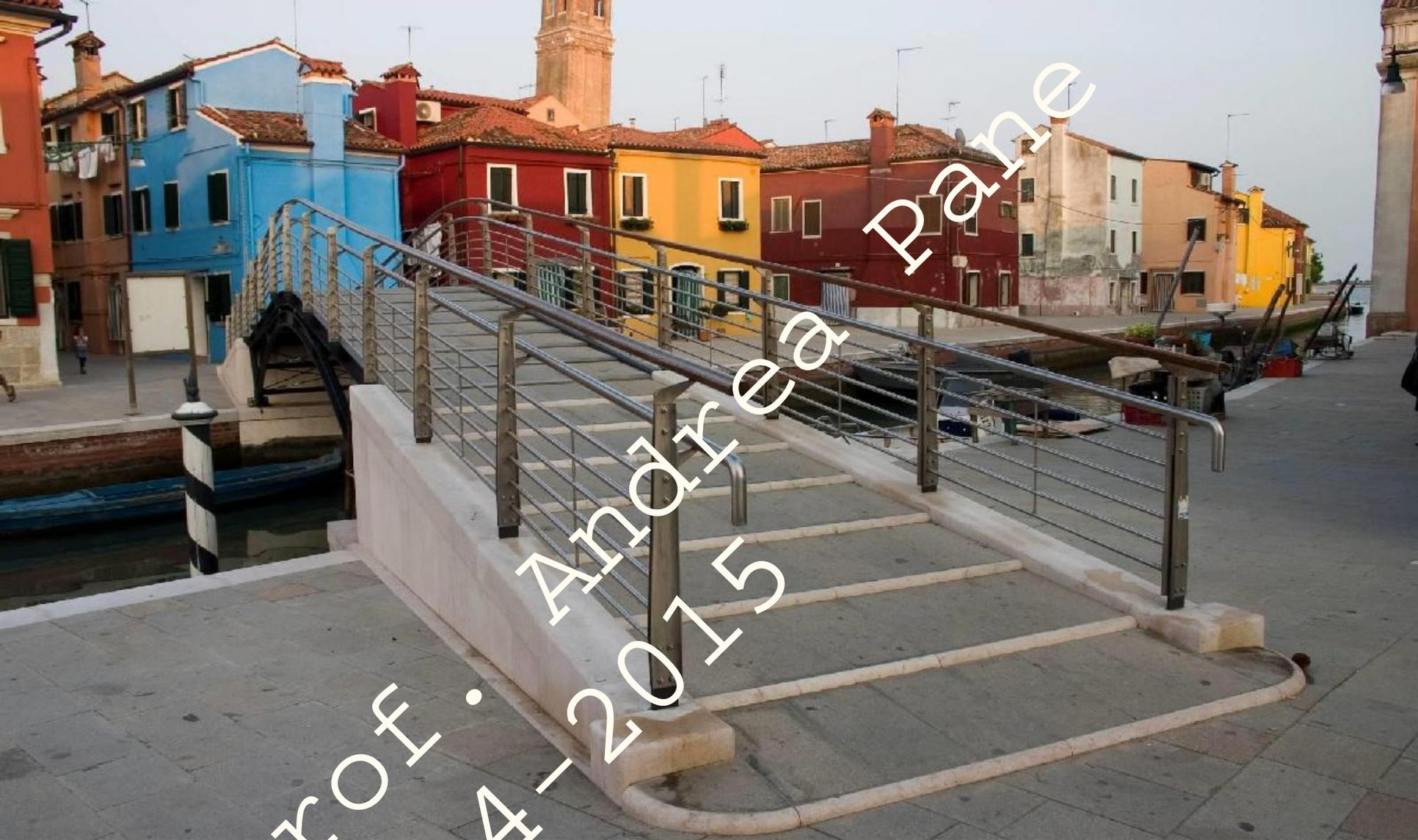
**Rampa con gradino agevolato.** Si tratta di una soluzione parziale a cui si può ricorrere qualora non sia possibile realizzare una rampa a norma. La rampa a gradino agevolato presenta gradini con pedate molto profonde e alzate di limitato spessore (circa 8 cm) con profilo a toro smussato. Risulta accessibile alle persone su sedia a ruote, purché in presenza di accompagnatore, o se dotate di carrozzina elettrica.
