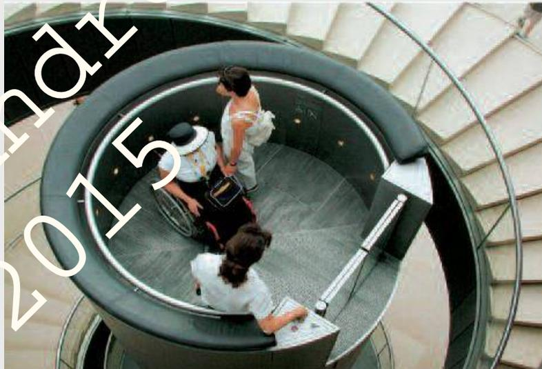
Parigi, Museo de' Louvre. La "soluzione alternativa", realizzata da I. M. Pei all'interno della Piramide per l'accesso al museo, fonde insieme il meccanismo di un ascensore oleodinamico con alcuni elementi caratteristici di una piattaforma elevatrice, tra cui l'assenza del vano corsa e la cabina scoperta.
